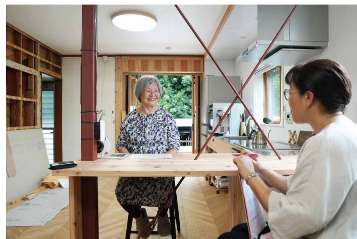
さらに奥の窓を掃き出し窓にし、手前の鉄骨を利用してカウンターを作成。
