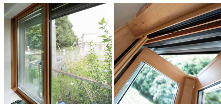
腰高窓には内窓を追加し(左)、掃き出し窓は高断熱タイプを使用(右)。断熱性能が向上し、年中過ごしやすいです。
