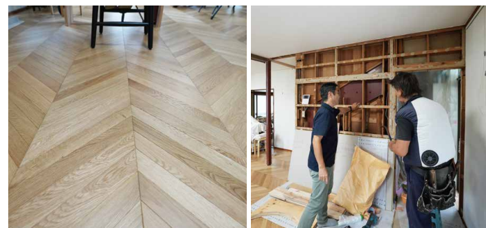
段差をなくした床は奥様念願の「フレンチヘリンボーン」を採用(左)。現在、階段下の収納を、かがまなくてもしっかり引き出し式に改装中(右)。
