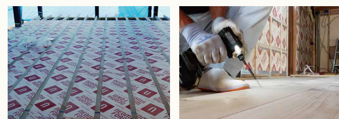
床と壁、天井裏にも断熱材を入れ快適な空間を実現しました
